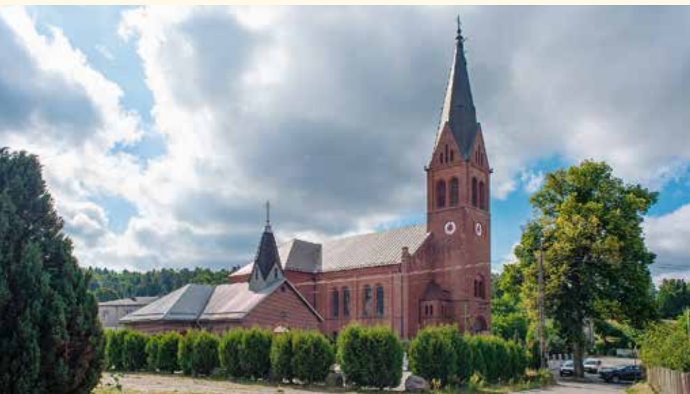
Kaplica przedpogrzebowa na tle kościoła – 2018 r. (zdj. Piotr Zatoń)
